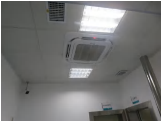
图 3-27 碘分装室进排风口
