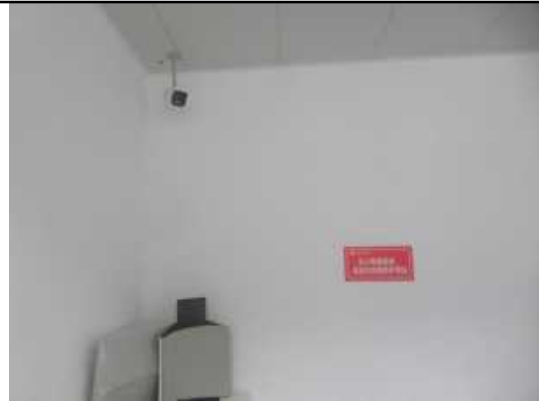
图 3-32 PET/CT 机房内摄像头
