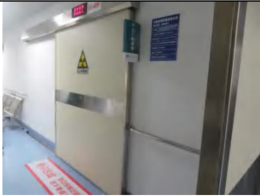
图 3-13 受检人员出入机房防护门
